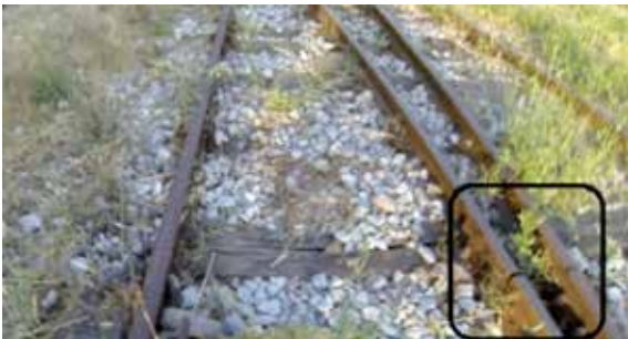
İki ray arasında imbisat genişliği kontrolü
