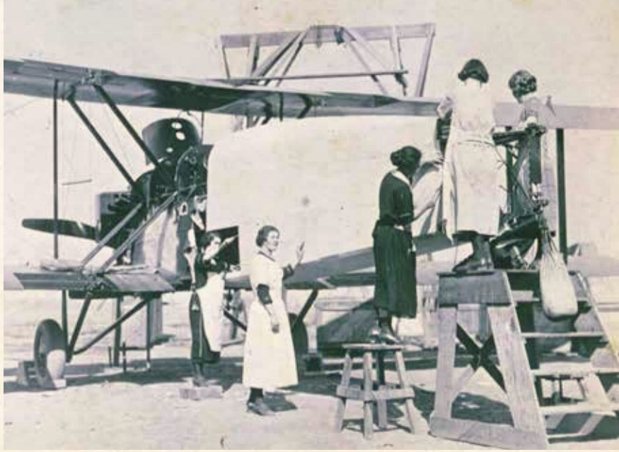
Douglas'ın kadın çalışanları, havadan dünyayı dolaşacak uçağın gövde kaplamasını hazırlıyorlar. Clover Park, 1924
