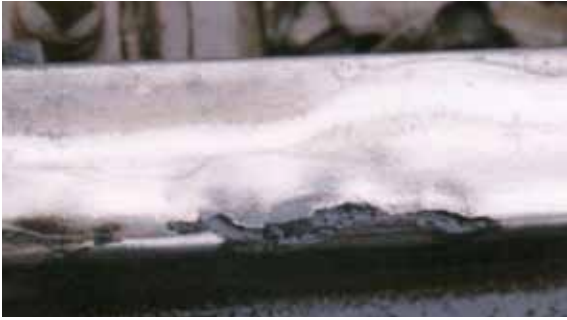
Ray üzerinde oluşan kabuklanma
