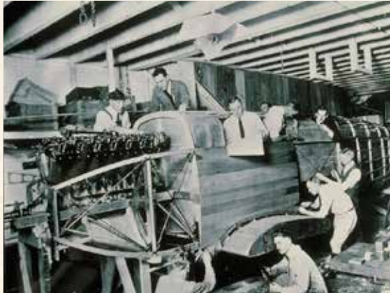
Douglas Aircraft Company'nin erken dönem uçaklarından birinin montajı. Santa Monica, 1921
