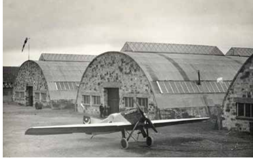
‘TOMTAŞ’ Kayseri Tayyare Fabrikası Tesisleri, 1928
