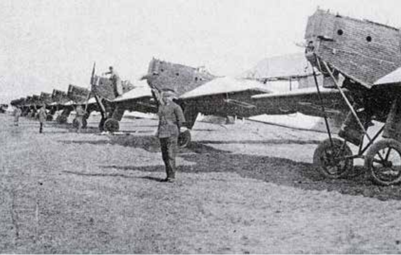
‘TOMTAŞ’ Kayseri Tayyare Fabrikası Tesisleri, 1928
