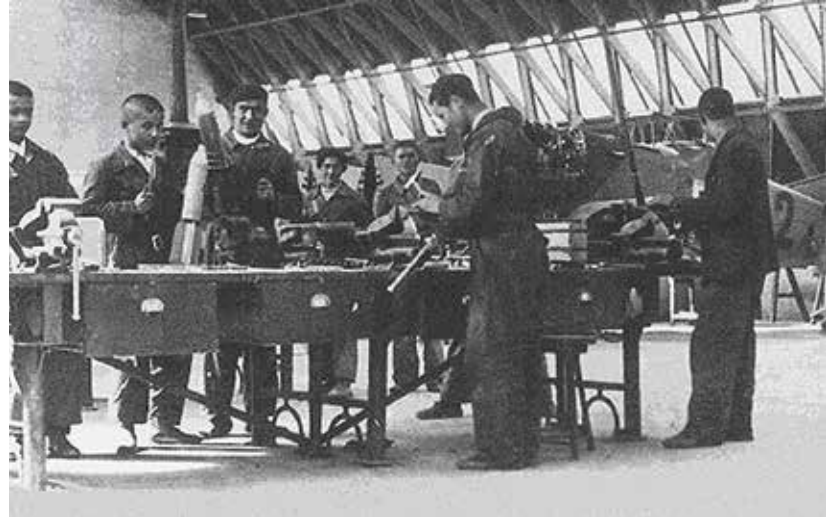
TOMTAŞ’ Kayseri Tayyare Fabrikası Tesisleri, 1928
