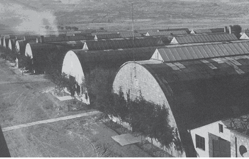
‘TOMTAŞ’ Kayseri Tayyare Fabrikası Tesisleri, 1926
