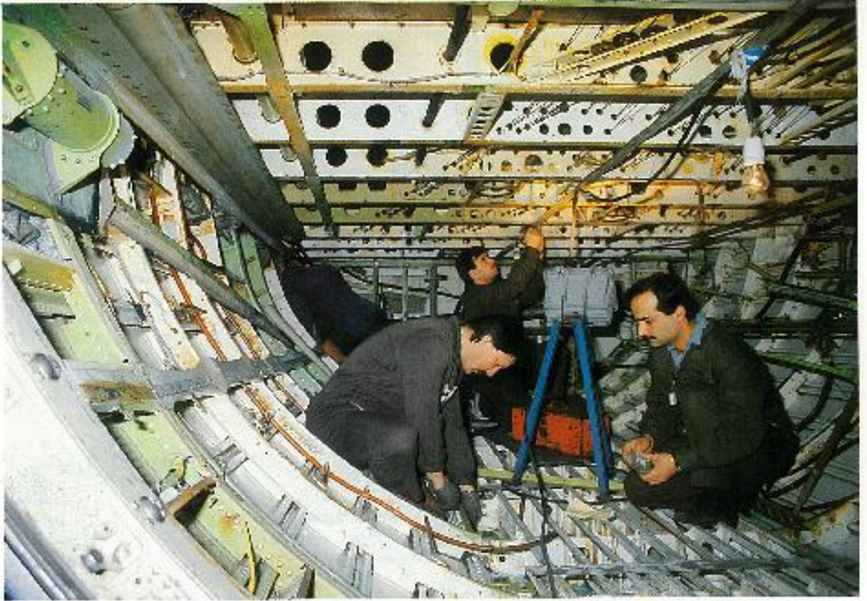
Korozyon giderme ve onarım çalışmaları yapısal tamir atelyesi ekiplerince yürütülür.
