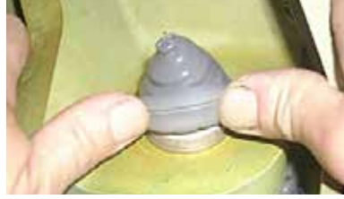
Yanlış sealant uygulaması
