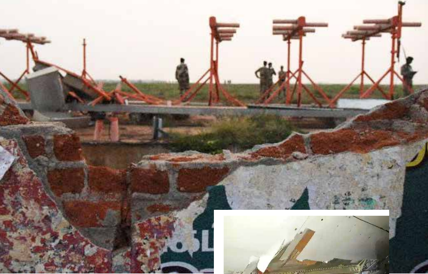
Localizer antenin ve antenin çevresindeki duvarın, uçak çarptıktan sonraki fotoğrafı
