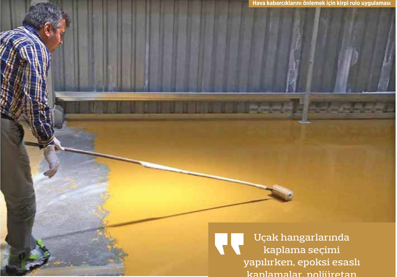
Hava kabarcıklarını önlemek için kirpi rulo uygulaması
